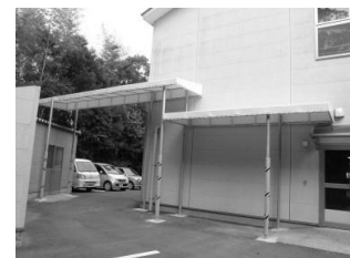
建物裏に雨除けのテントをつけました
